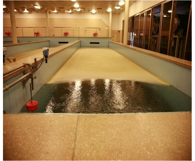
عملية التخثير ويلاحظ تجمع المواد المراد ترسيبها على سطح الماء
